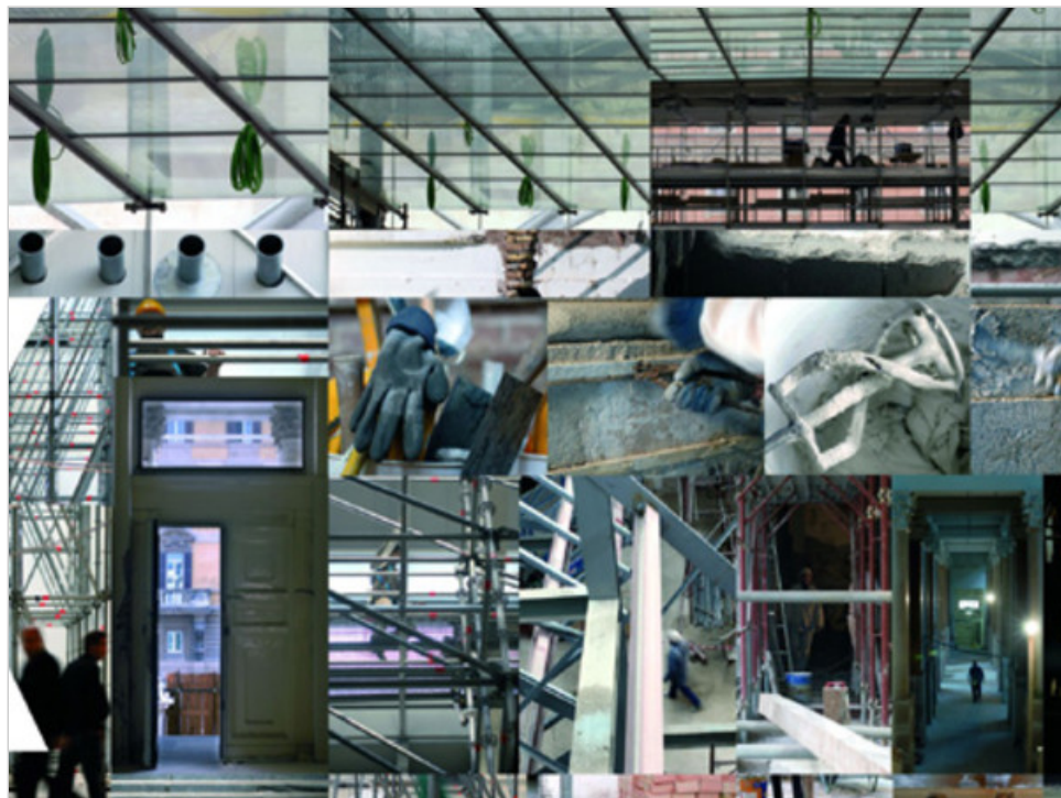
collage foto lavori in corso
